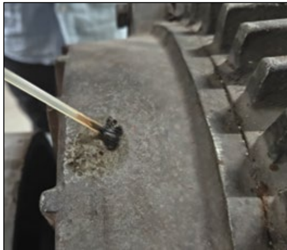
図 7:設備の設置表面に促進剤を塗布
