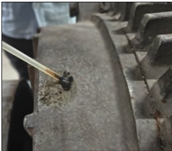
図 7.設備の設置表面に促進剤を塗布
