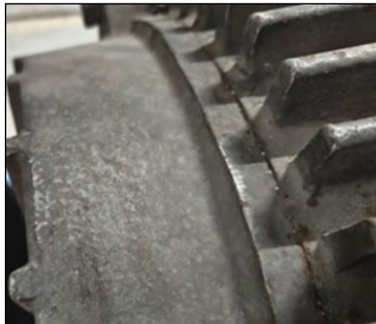
図 6: 設備の設置表面の付着物の除去
